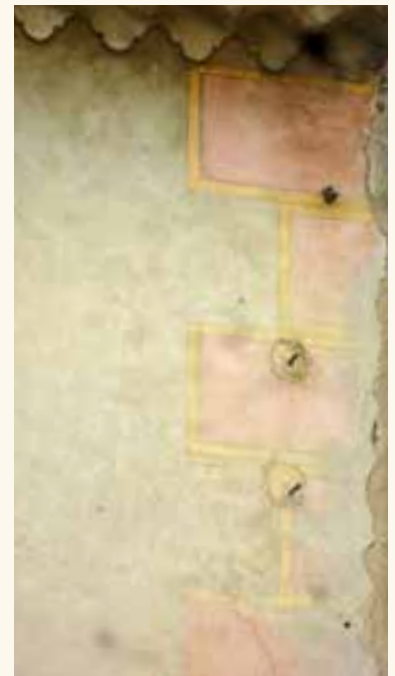
Les vestiges de décors anciens peuvent orienter les travaux de ravalement
