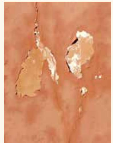
La mise en œuvre de matériaux inappropriés aboutit à l'apparition de pathologies, préjudiciable à la présentation de la façade, mais aussi à la pérennité des maçonneries !!!
