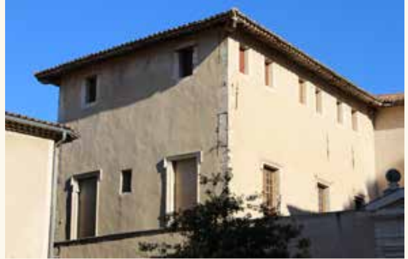
Un enduit traditionnel à la chaux se caractérise par une douceur de teintes qui varient légèrement selon les conditions météorologiques
